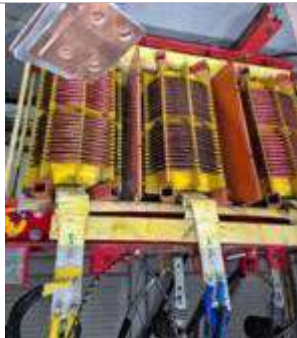
CAMBIO DE CALIBRE EN LOS DPS DEL TRANSFORMADOR DE 225KVA EN SUBESTACIÓN N°1
