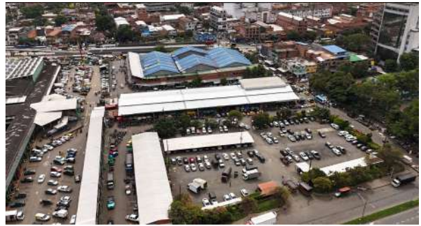
Cambio de cubierta quincalla
