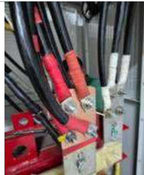
CAMBIO DE CALIBRE EN LOS DPS DEL TRANSFORMADOR DE 225KVA EN SUBESTACIÓN N°1
